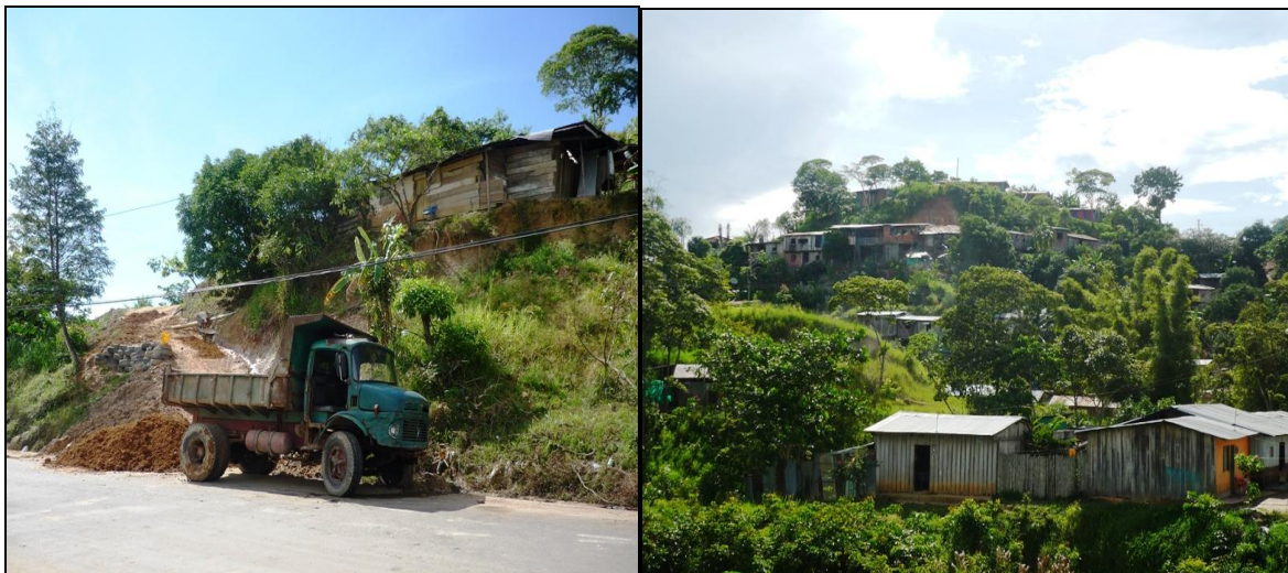
Viviendas en zonas de altas pendientes y suelos inestables.
