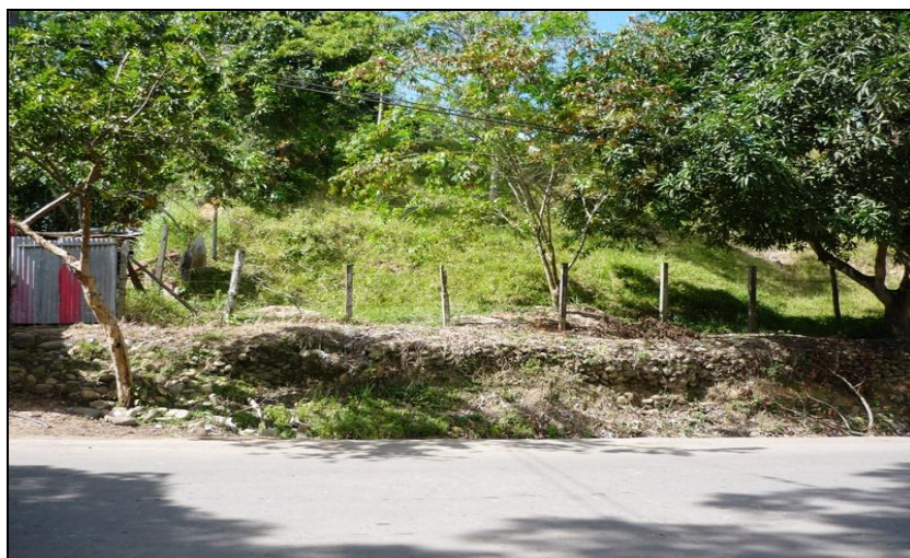
Zona de deslizamiento por fenómenos de reptación con obras de mitigación actualmente deterioradas.
